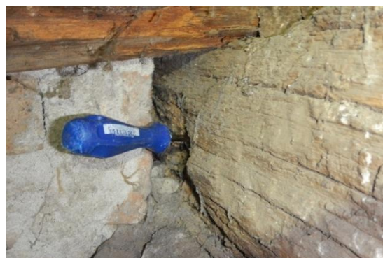
Figura 2. Valutazione speditiva del degrado in appoggio.
