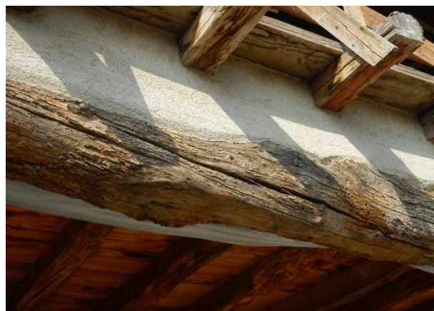
Figura 6. Deviazione fibratura in luce.
