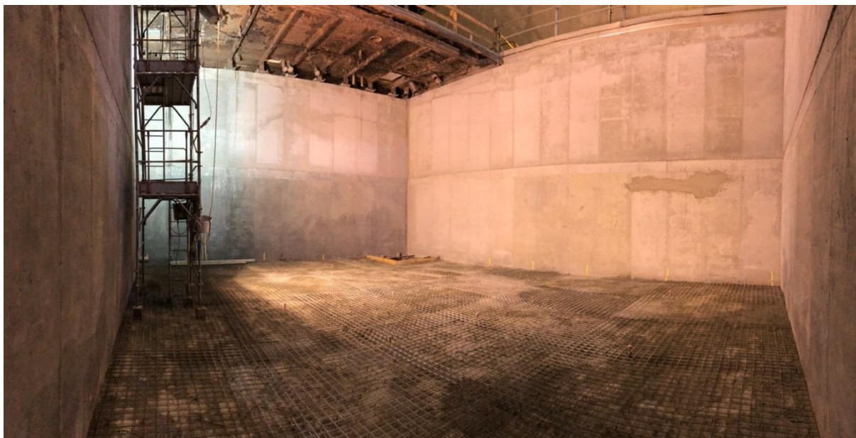
Figura 3. Vasca di accumulo del FORSU.
