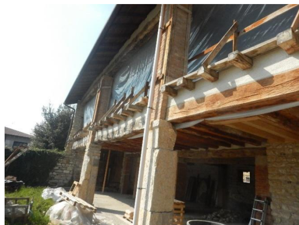
Figura 23. Vista del corpo di fabbrica più corto.
