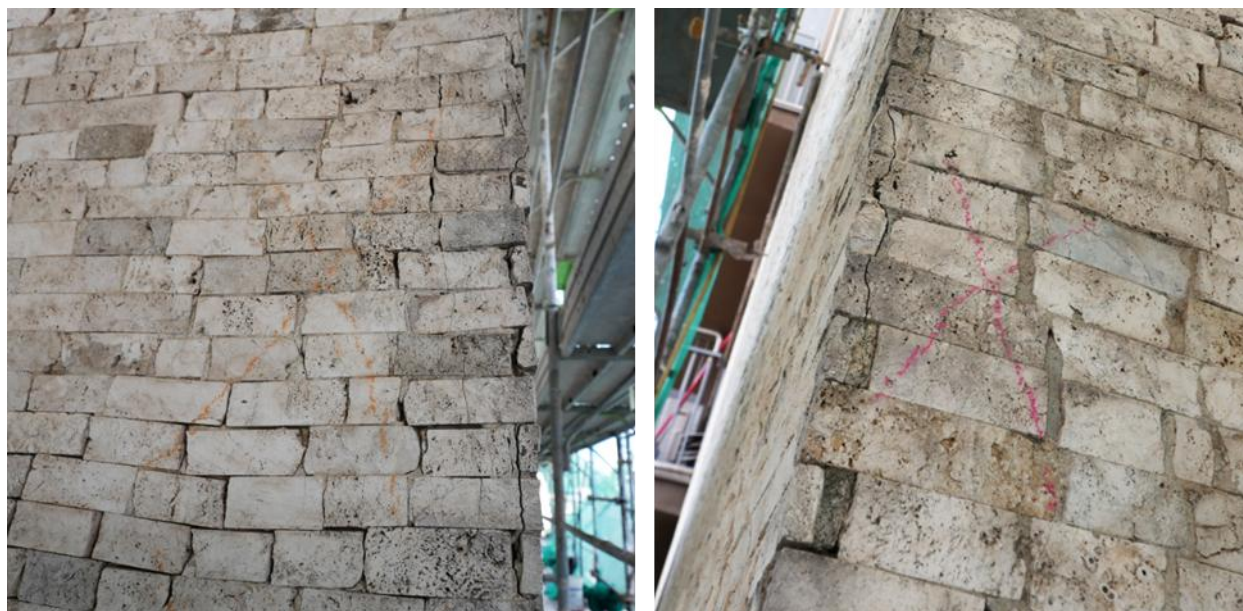
Figura 15. Intervento: identificazione delle aree da tassellare post battitura manuale.
