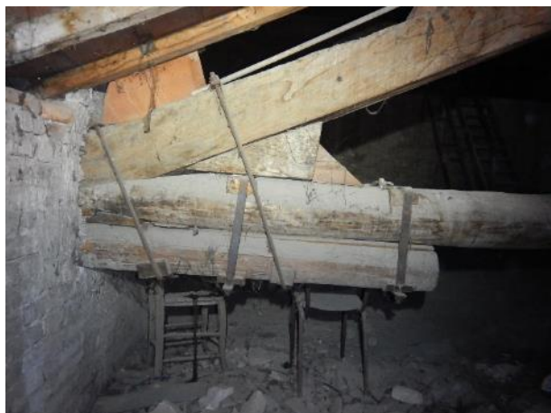
Figura 18. Consolidamento appoggio con staffatura metallica e sottomensola.
