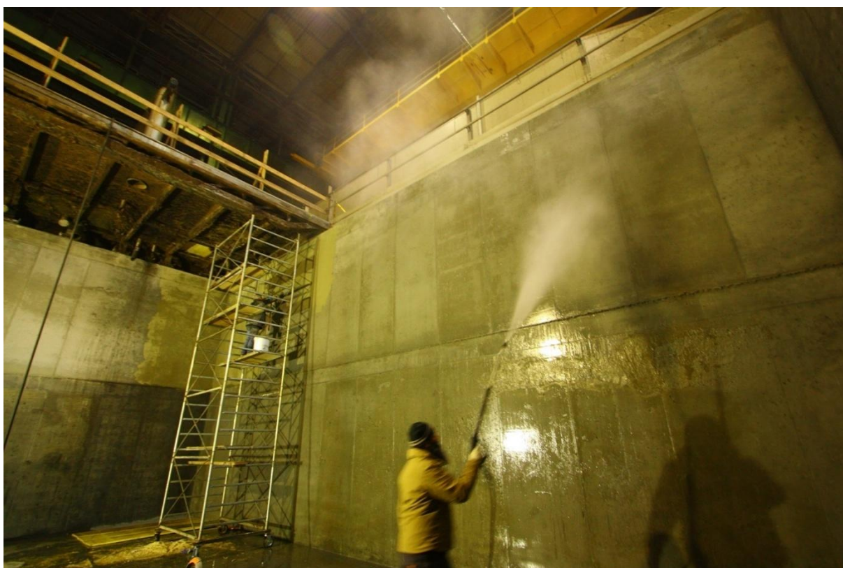
Figura 7. Saturazione con acqua delle superfici in condizioni S.S.A. (Sature a Superfici Asciutte).
