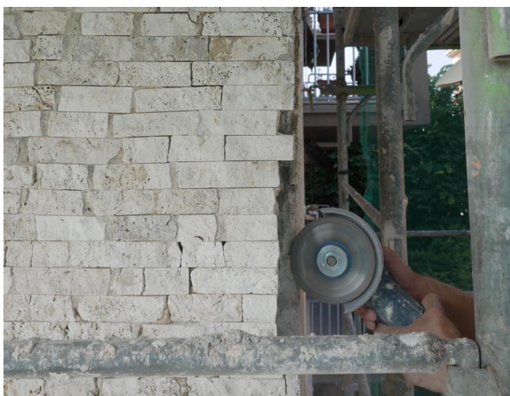
Figura 20. Intervento: lavorazione dei bordi tramite fresatura.
