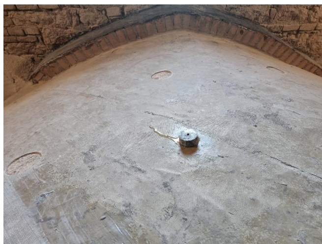
Figura 4. Il campo prove per verificare l'efficacia degli interventi sul Santuario di Rivotorto dopo quaranta anni dall'applicazione avvenuta nel 1984.
