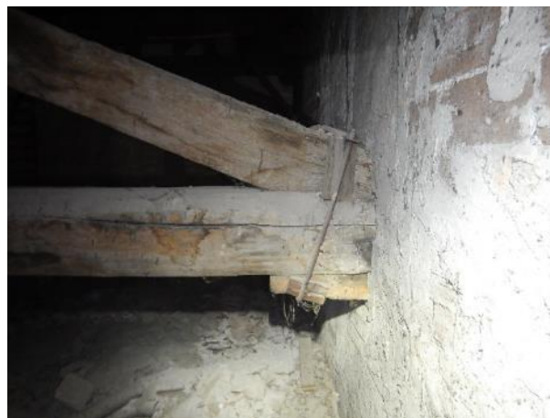
Figura 19. Consolidamento appoggio con semplice staffatura.
