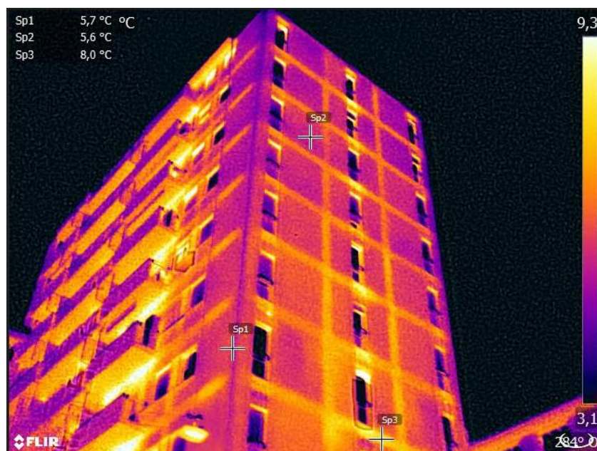
Figura 10. Immagine Termografica dove è possibile interpretare la struttura dell'edificio.
