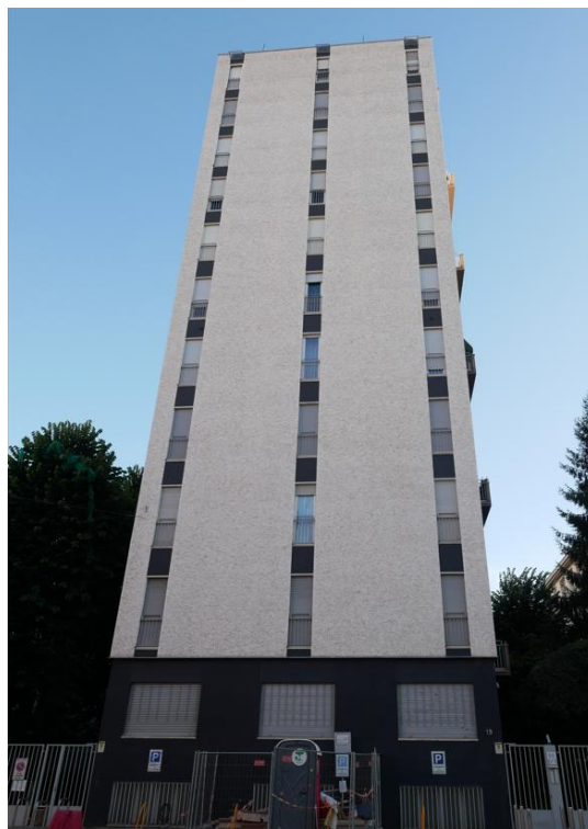
Figura 30. Facciata nord al termine dell'intervento.
