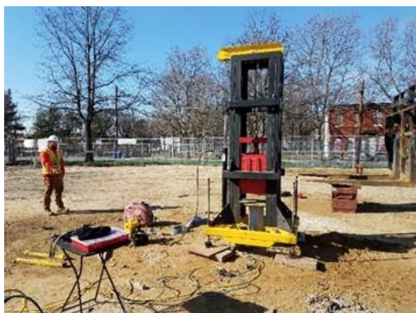
Foto 1. Strumentazione della testa del palo e installazione del maglio.
