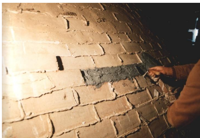
Figura 1. Intervento di rinforzo con GFRP della cupola della chiesa di S. Biagio di Frassineto (AR) eseguito nel 1984.
