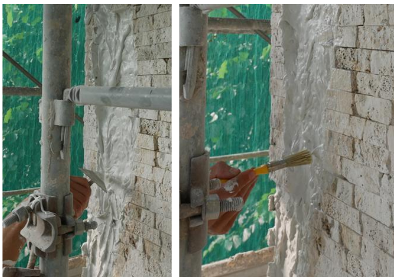
Figura 21. Intervento: stesura dello strato adesivo e lisciatura a pennello.
