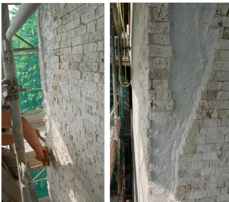
Figura 22. Intervento: a sinistra, pulitura della superficie circostante; a destra, lo strato finito prima della posa del travertino.
