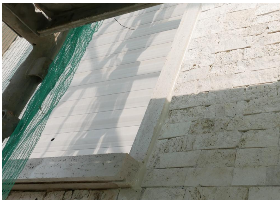
Figura 29. Intervento: posa di silicone lungo le cornici lapidee.
