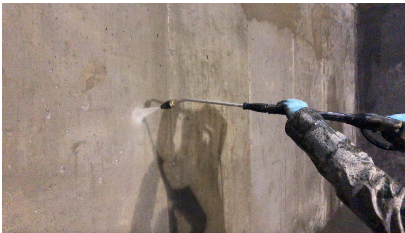
Figura 6. Lavaggio superficiale con idropulitrice per la rimozione dei residui di olio disarmante.
