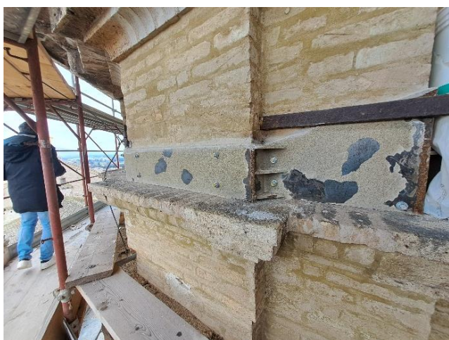
Figura 7. Intervento di rinforzo con SRG della cupola con sistema di monitoraggio integrato mediante fibra ottica.
