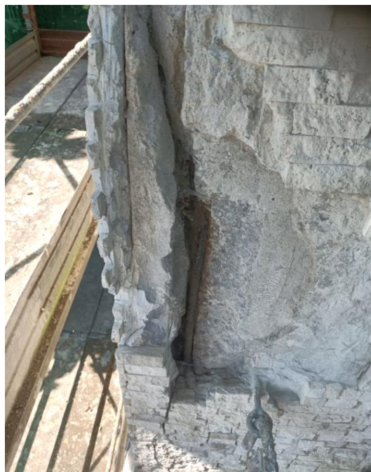
Figura 17. Intervento: scarificazione con messa in luce del ferro d'armatura ossidato.
