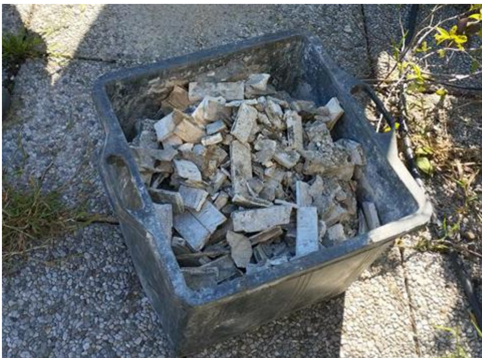
Figura 14. Battitura in corda: rimozione di alcuni elementi.
