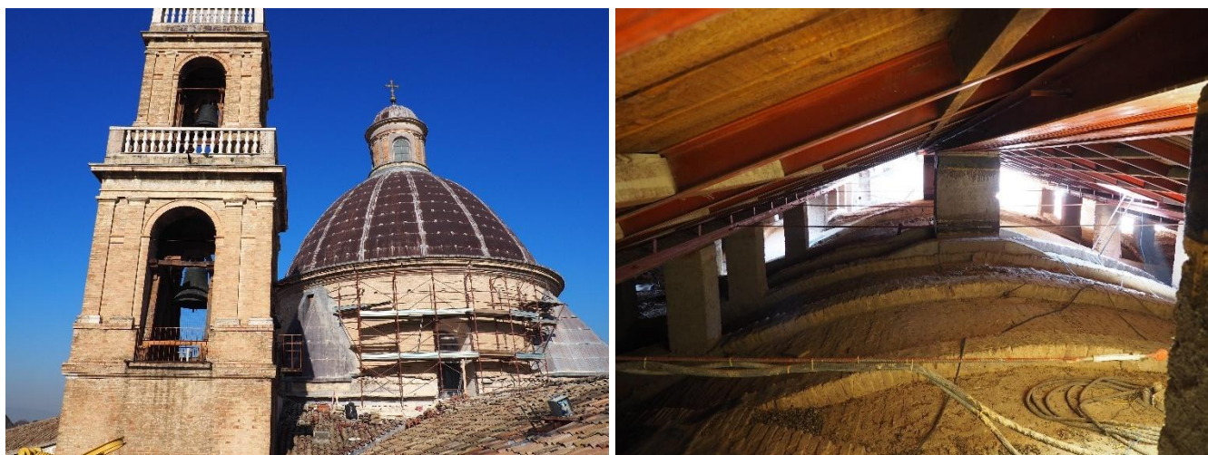
Figura 2. La Cattedrale di San Feliciano di Foligno (PG) a sinistra e l'intervento sull'estradosso delle volte a destra.
