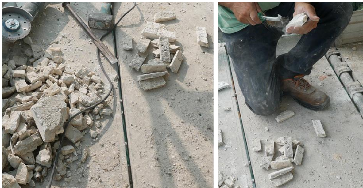
Figura 23. Intervento: pulitura manuale dello spaccatello di travertino rimosso.
