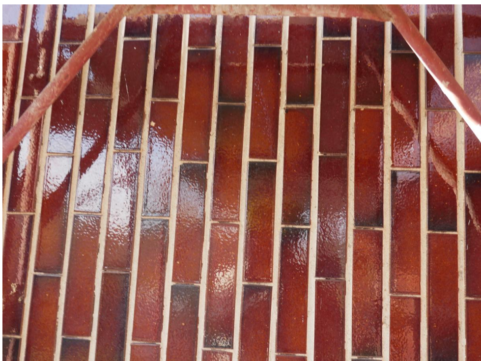
Figura 3. Piastrelle clinker smaltate (tipologia molto diffusa come rivestimento delle facciate degli edifici di Milano costruiti nel secondo dopoguerra).
