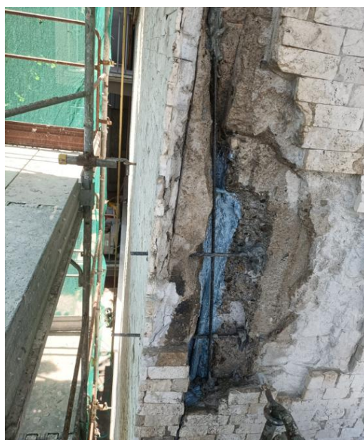
Figura 18. Intervento: protezione del ferro d'armatura e posa di barre pultruse disposte a griglia.
