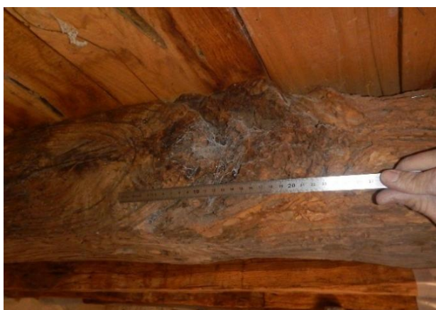
Figura 24. Difetto anatomico per nodosità.
