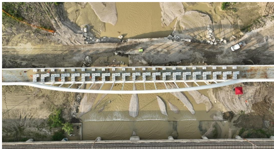
Foto 2. Posizionamento delle cisterne in plastica sull'impalcato.
