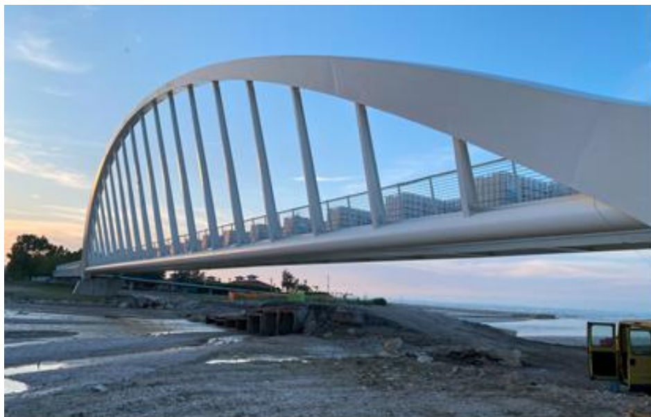
Foto 4. Realizzazione del carico.
