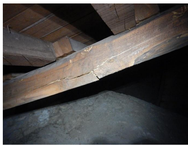
Figura 10. Rottura intradossale.
