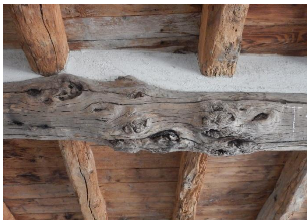
Figura 5. Nodosità di varie dimensioni.
