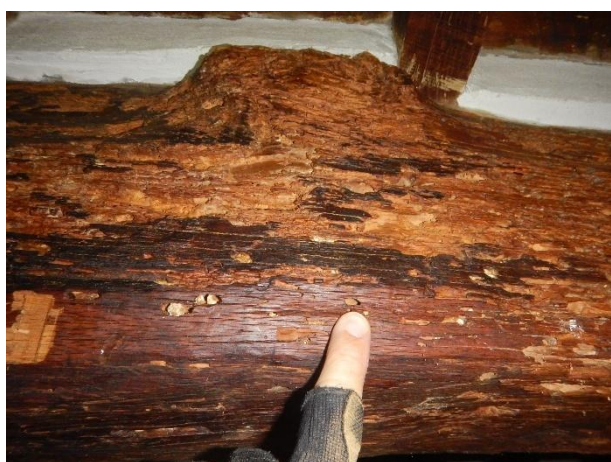
Figura 11. Attacco insetti cerambicidi su trave.
