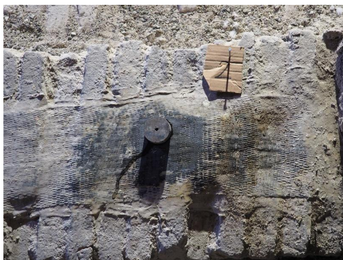
Figura 3. Il campo prove per verificare l'efficacia degli interventi dopo vent'anni dall'applicazione avvenuta post sisma '97.
