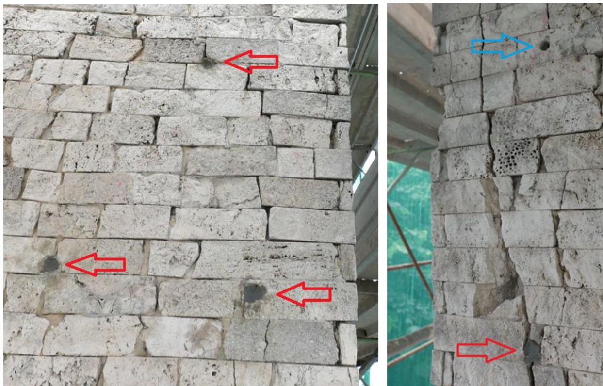
Figura 16. Intervento: esempio di alcuni tasselli inseriti (freccie rosse) e di foro in cui verrà inserito il tassello (freccia azzurra).
